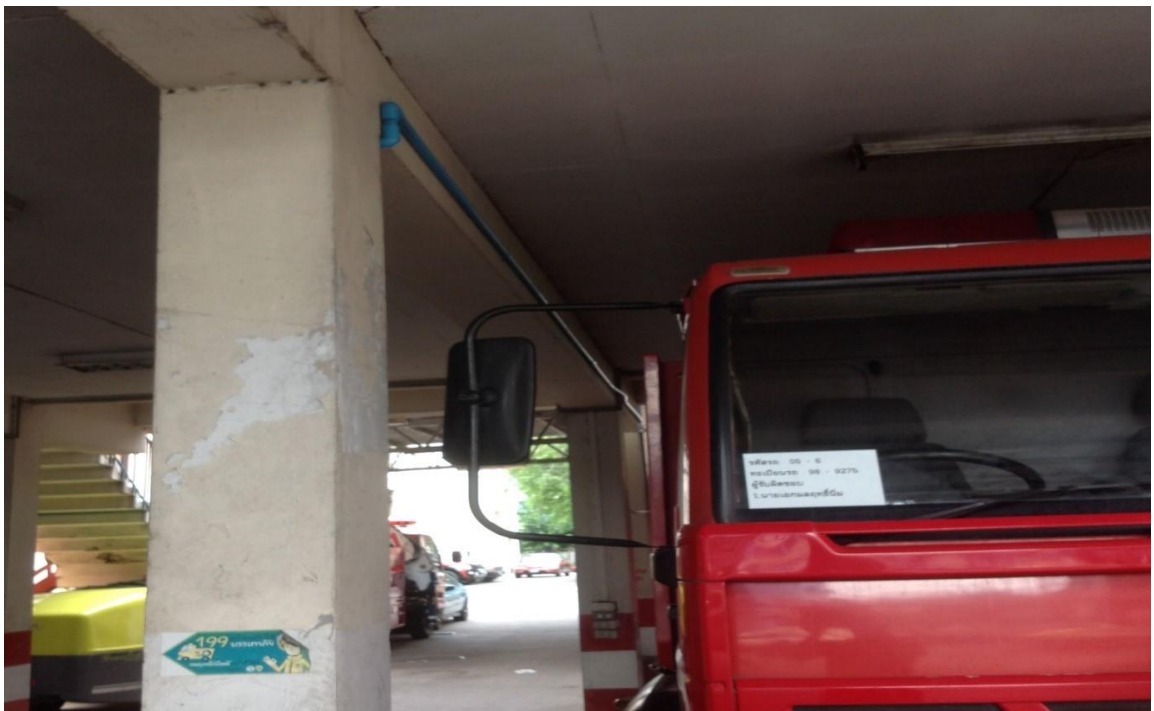
เดินท่อตามโครงสร้างอาคาร
