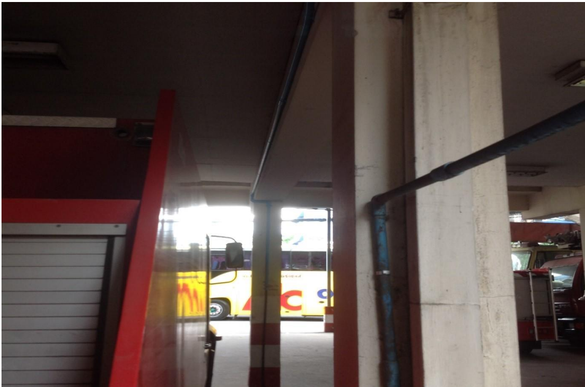
เดินท่อตามโครงสร้างอาคาร
