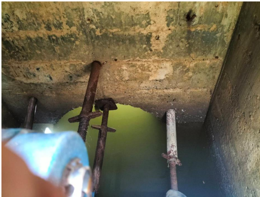
ภาพการติดตั้งอุปกรณ์ค้ำบานประตูระบายน้ำ Flap Gate ป้องกันน้ำไหลลงคลอง
