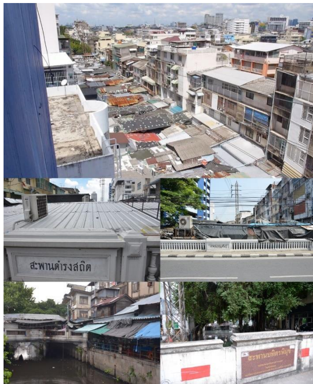
ภาพก่อนปรับปรุงภูมิทัศน์คลองโอ่งอ่าง
