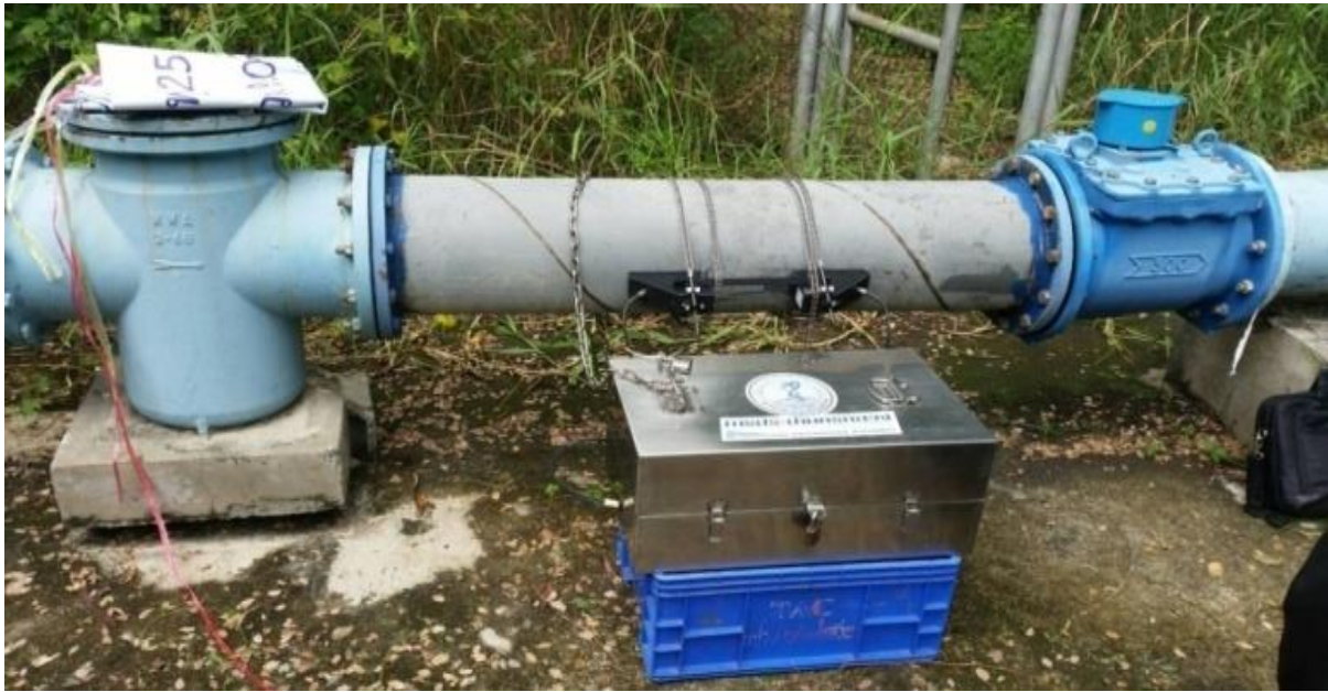
รูปที่ ๔ การติดตั้ง Portable Ultrasonic Flow Meter (UFM)
