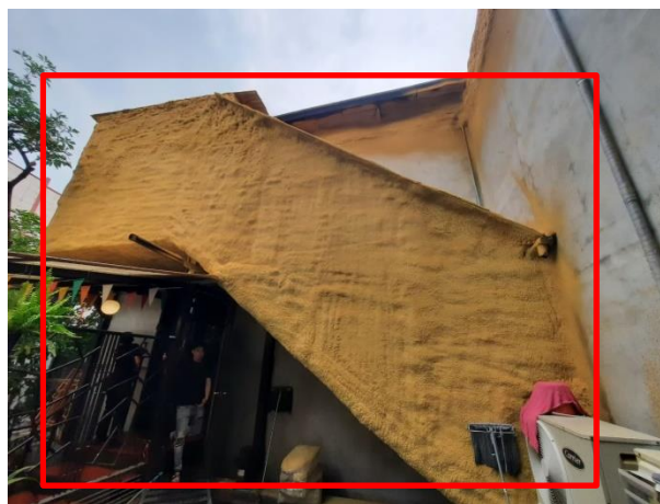
รูปที่ ๒ ฉีดยิปซัมบริเวณที่คาดว่าจะป็นช่องทางให้เสียงออก
