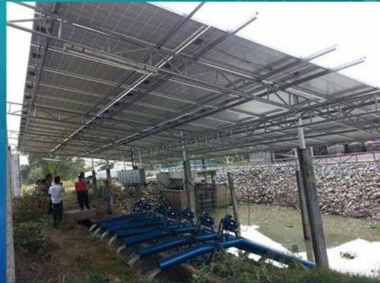
รูปแบบเครื่องสูบน้ำพลังงานแสงอาทิตย์ ที่ อบต. สิงหนาท จังหวัดพระนครศรีอยุธยา ใช้งานอยู่
