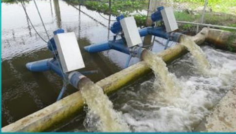
รูปแบบเครื่องสูบน้ำพลังงานแสงอาทิตย์ ที่ อบต. สิงหนาท จังหวัดพระนครศรีอยุธยา ใช้งานอยู่
