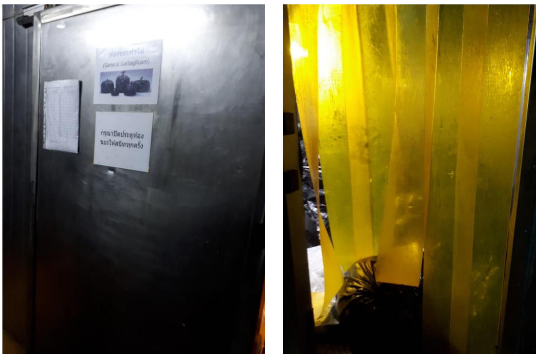
ภาพห้องจัดเก็บขยะทั่วไปที่มีการควบคุมอุณหภูมิเพื่อรอเขตมาจัดเก็บ
