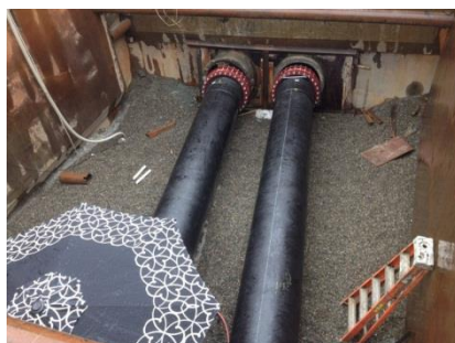
รูปที่ ๑๒ การปรับปรุงท่อเดิมโดยวิธี Sliplining
