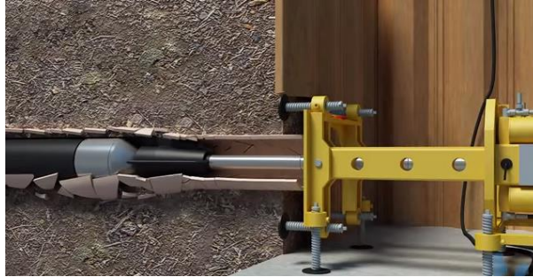
รูปที่ ๑๔ การปรับปรุงท่อเดิมโดยวิธี Pipe Bursting
