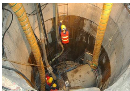
รูปที่ ๑๓ การปรับปรุงท่อเดิมโดยวิธี Pipe Insertion
