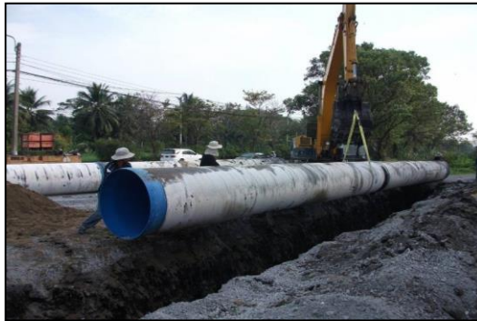
รูปที่ ๘ การวางท่อในพื้นที่ใหม่โดยวิธี Open Cut
