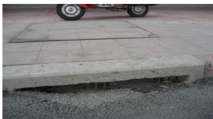
รูปภาพการปรับพื้นถนนปิดช่องทางระบายน้ำ
