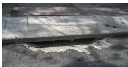
รูปภาพสภาพปากช่องทางระบายน้ำ
