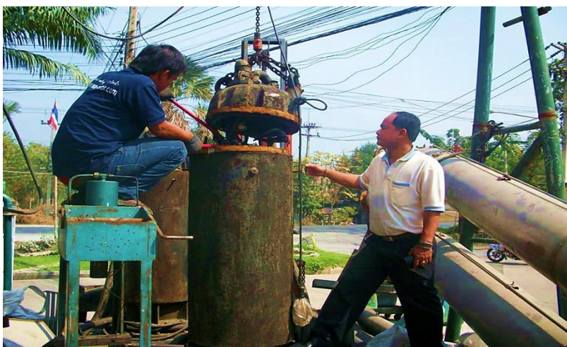
การซ่อมบำรุงเครื่องสูบน้ำไฟฟ้า
