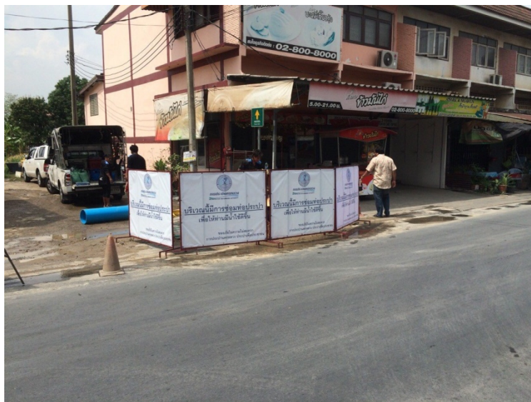
รูปภาพแสดงงานซ่อมท่อจ่ายน้ำประปาที่มีแผงกั้นจุดงาน (รูปแบบที่ยังไม่ปรับปรุง)
