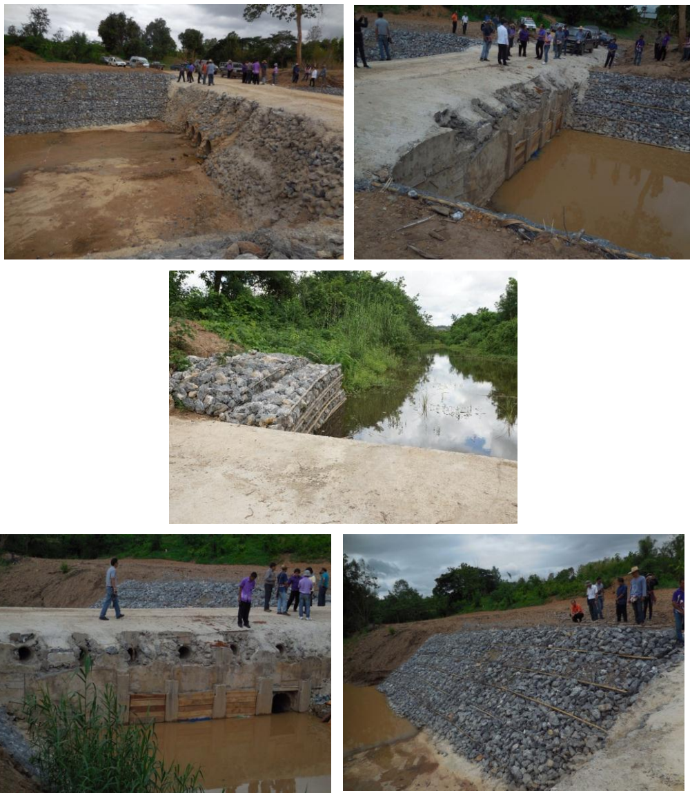
รูปที่ 3-7 ภาพการลงพื้นที่โครงการซ่อมแซมทำนบชะลอน้ำลำห้วยแม่สาคร บ้านใหม่เจริญราษฎร์
