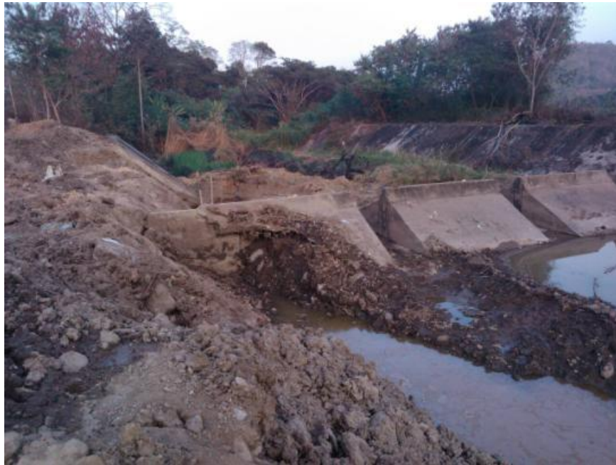
รูปที่ 3-4 ภาพระหว่างก่อสร้าง
