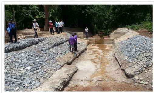
ฝายที่ปรับปรุงแล้วเสร็จ
