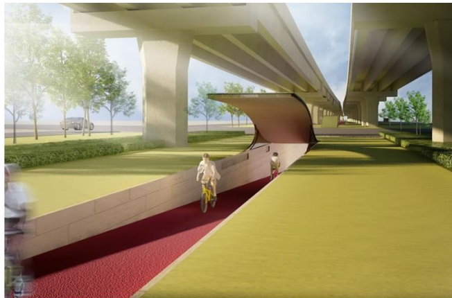
ทางลอด/ทางข้าม ทางลอดจุดกลับรถ ทางลอดสูง 2.50 เมตร ช่องทางจักรยานกว้าง 3.00 เมตร
