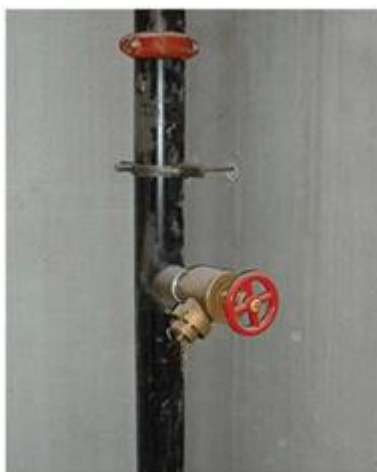
ภาพท่อยืนประเภทที่ ๑ ประกอบด้วยวาล์วสายฉีดน้ำดับเพลิง
